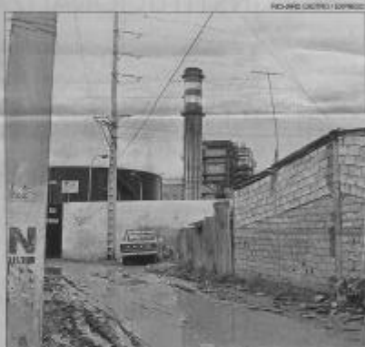
La central Trinitaria tiene 133 megavatios de capacidad instalada y empezó a operar en 1997. Ocupa 29.286 metros cuadrados.
