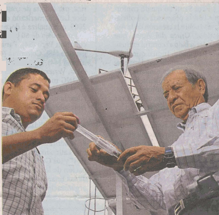
CONTROL. Los ingenieros Rubén Hidalgo y Marco Pazmiño revisan un componente del sistema de energía alternativa de la Espol, debajo de los paneles solares y el molino de viento.
