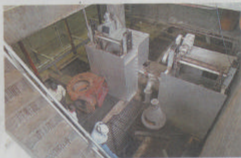
La planta de pretratamiento de La Pradera cuenta con una cámara de cribas, sistema que retira materiales gruesos mayores a una pulgada.
