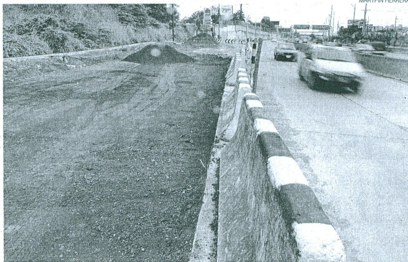
La mañana de ayer toda la calzada de hormigón del sector afectado en el avenida del Bombero, ya había sido removida por maquinaria municipal.
