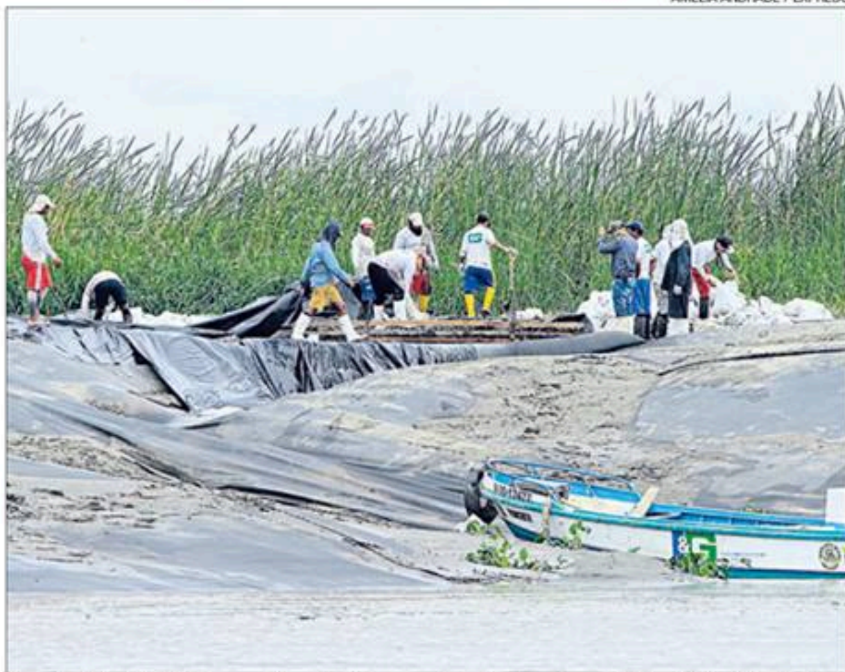
Dragado. La instalación de una malla geotextil fue necesaria antes de colocar material extraído del fondo del río.
