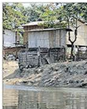
Riesgo. Las casas en las riberas sufren daños en inundaciones.
